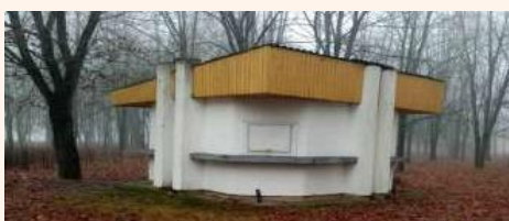
Здание кассы г. Щучин, ул. Советская, городской парк Год постройки: 1986 Площадь здания (кв. м.): 20,7
