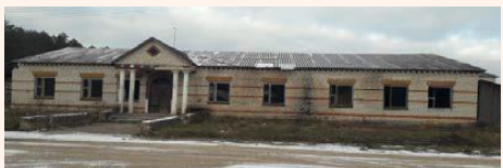
Комплекс зданий и сооружений (реммастерская, дом механизатора, гараж) д. Новины
