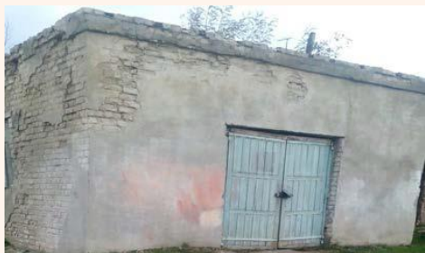
Здание центрального теплового пункта аг. Жировичи Год постройки: 1982 Площадь здания (кв.м.): 112,0
