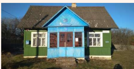
Здание комплексного приемного пункта д. Бершты, ул. Центральная, 7 Год постройки: 1960 Площадь здания (кв. м.): 74,0
